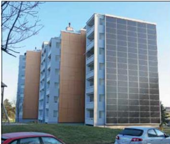
Solarfassade im Pfisterhölzli.
