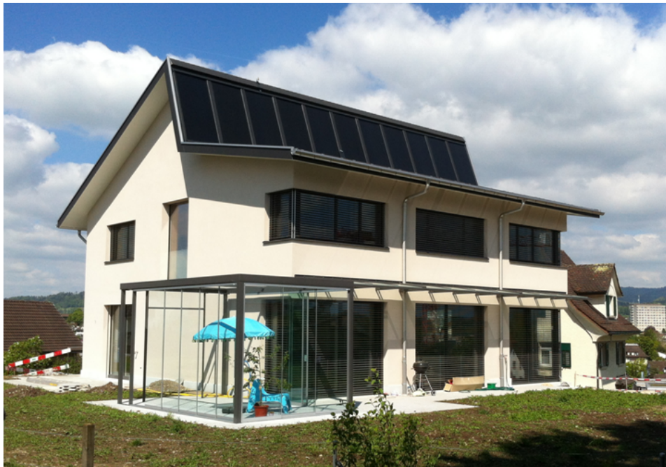
Das Plusenergiehaus an der Frobergstrasse in Wetzikon produziert 2,5-mal mehr Strom im Jahr als es selber verbraucht. Die optimierte Dachform sorgt für maximale Solarerträge.
