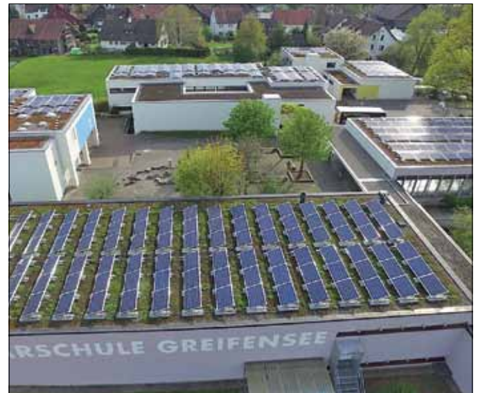
Die Solaranlage auf den Dächern des Schulhauses Breiti. (zvz)
