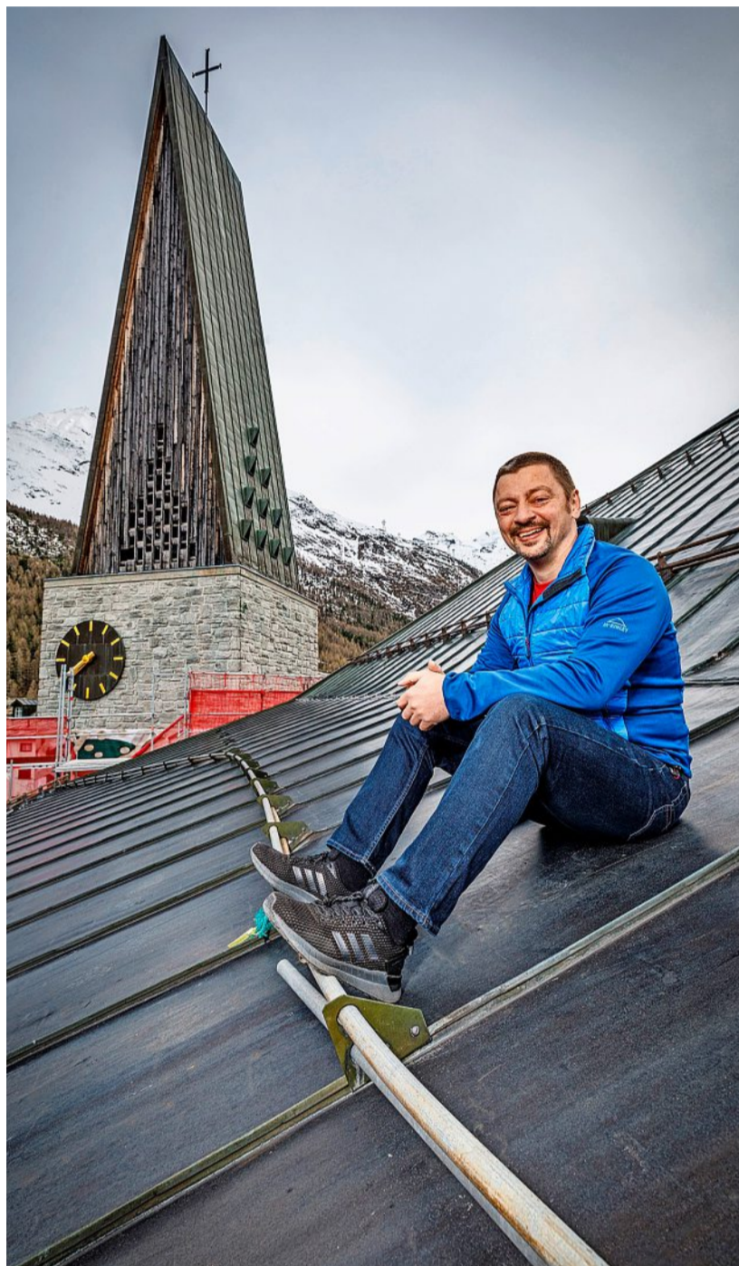
Das neue Dach auf Konrad Rieders Kirche verwandelt Licht bald in Strom
